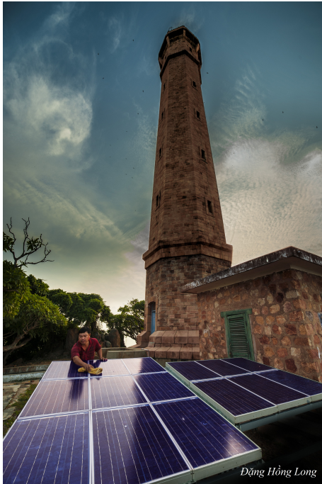
Illustration 1: En 2015, le photovoltaïque au Vietnam concernait principalement îles, phares et autres régions éloignées.
